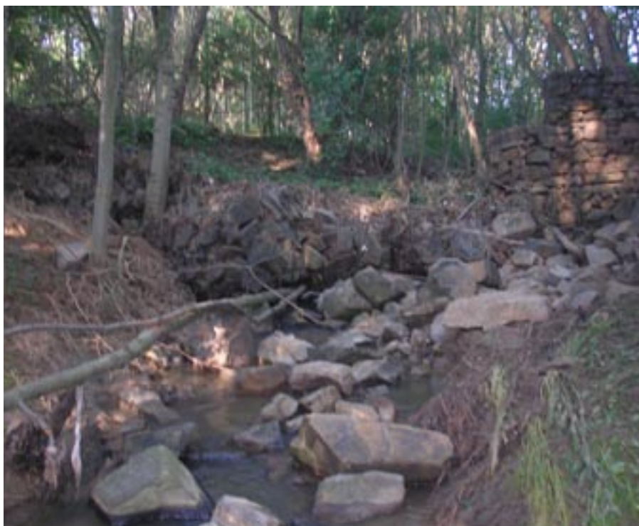
Stav Věžeckého potoka byl i před záplavou v katastrofálním stavu. Snímek byl pořízen po letošní záplavě.
